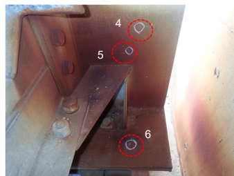
図6 実橋での測定
