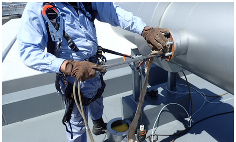
現地計測の様子
