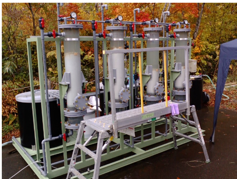
温泉排水処理試験装置 (フィールドスケール)
