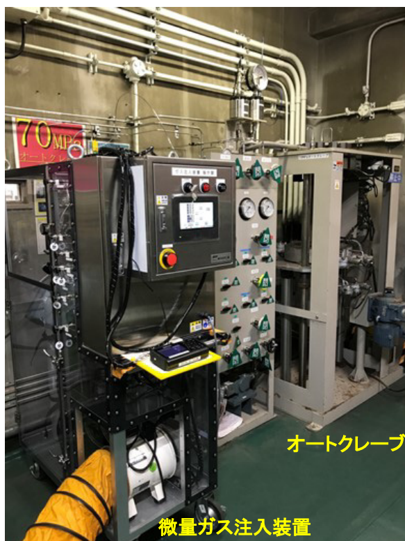
オートクレーブ試験機と微量ガス注入装置
