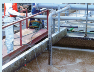
写真 現地における電位測定状況
