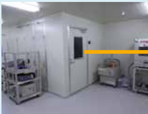
写真2 電解液注液室
